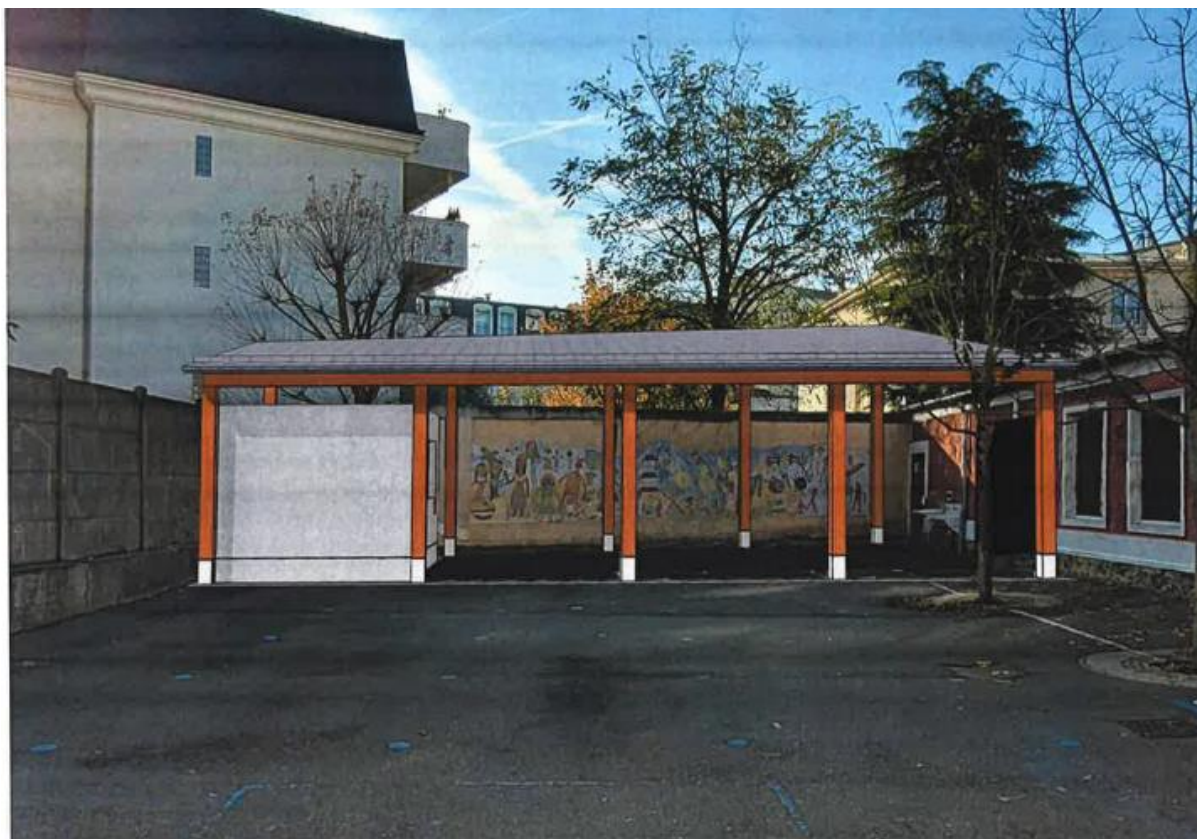
Après les travaux
